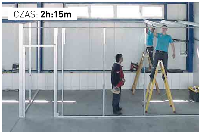
Montaż konstrukcji sufitu
