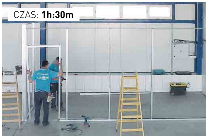
Montaż ościeżnicy drzwi
