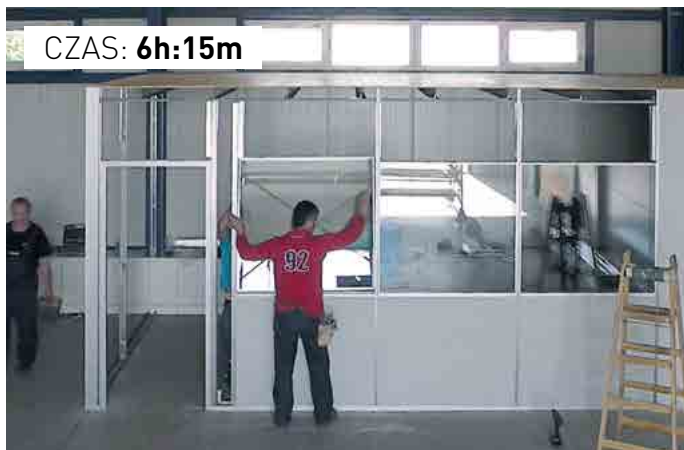
Montaż szklanych paneli
