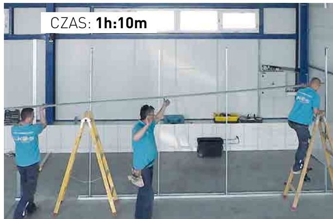
Montaż konstrukcji pomocniczej
