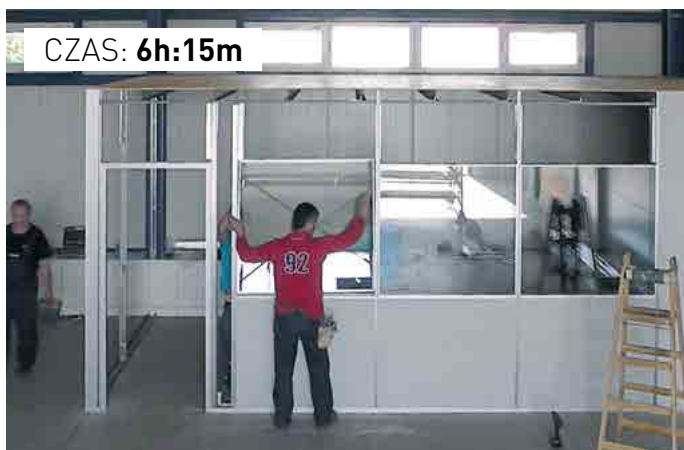
Montaż szklanych paneli
