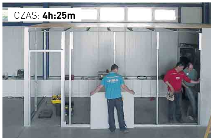
Montaż pełnych paneli
